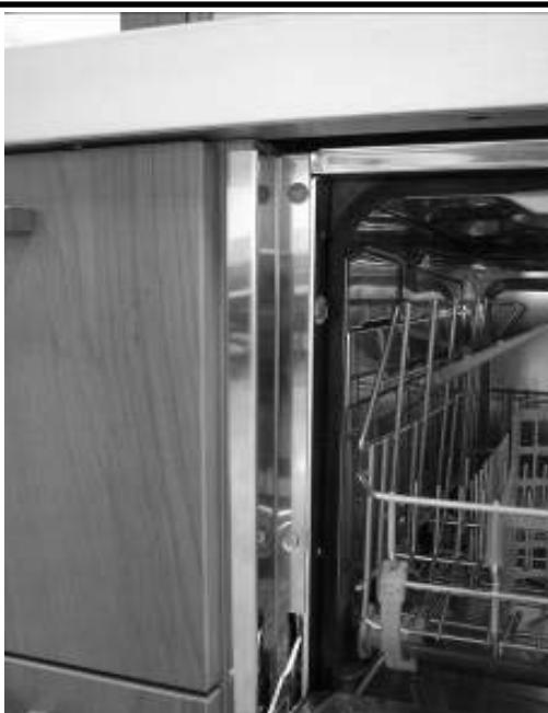
Encastrar a máquina e, se necessário, fixá-la lateralmente nos furos dos perfis laterais.
