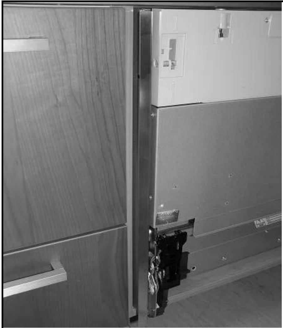
Bouw de machine in en blokkeer hem indien noodzakelijk in de gaten van de zijprofielen.
