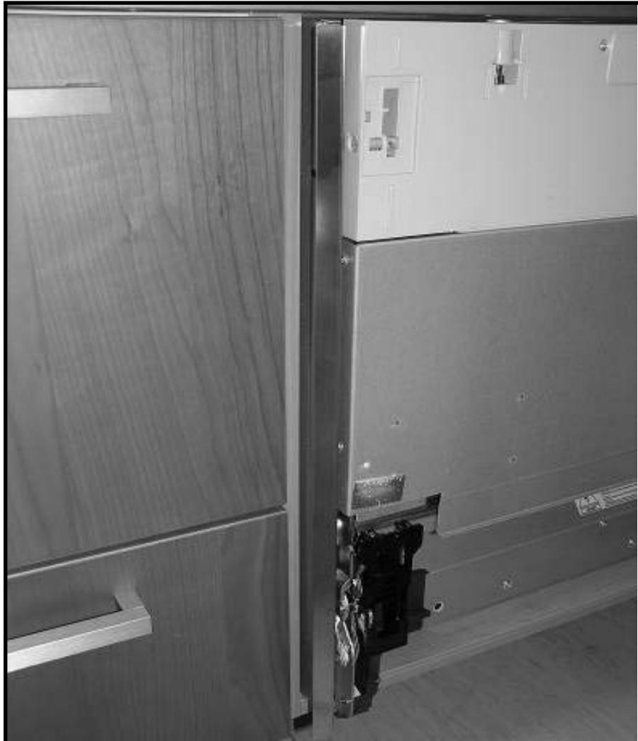
Das Gerät einsetzen und erforderlichenfalls mit Hilfe der Löcher der Seitenprofile seitlich befestigen.
