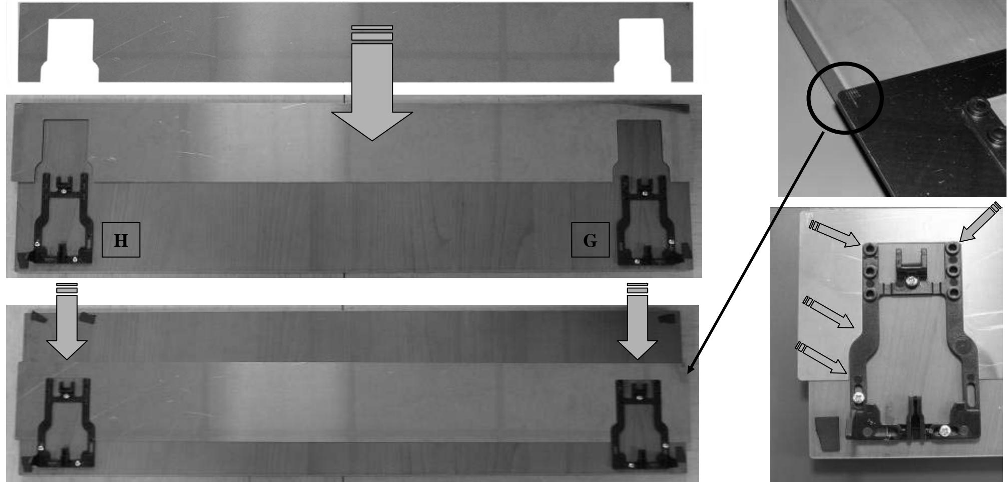
**DE - Positionierung der Sockelbefestigungen:** Die Position der Sockelbefestigungen (**G-H**) mit Hilfe der Pappschablone (beim Zubehör des Geschirrspülers) einstellen, mit der Metallschablone kontrollieren, ob die Position stimmt, und dann die Schrauben fest anziehen.
